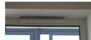
оконный приточный клапан
