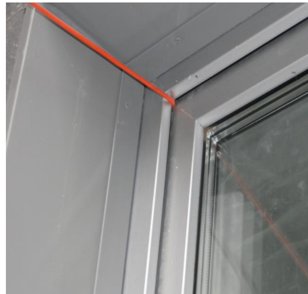
Проложен кабель через оконный притвор
