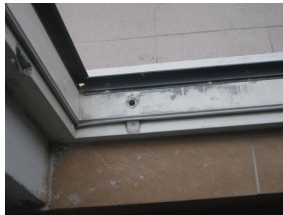
Износ уплотнительных резинок из-за отсутствия должного ухода
