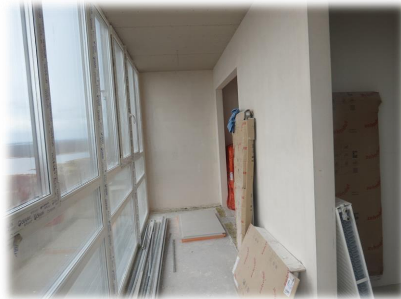
Изменение фасадного остекления и подшивка потолка
