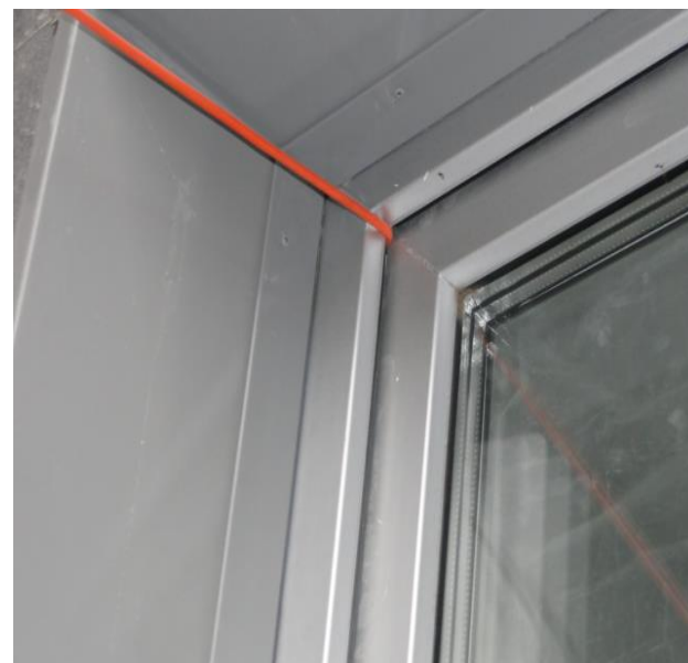
Проложен кабель через оконный притвор
