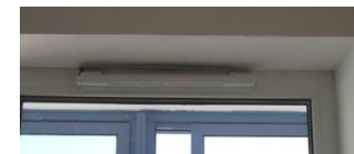
оконный приточный клапан
