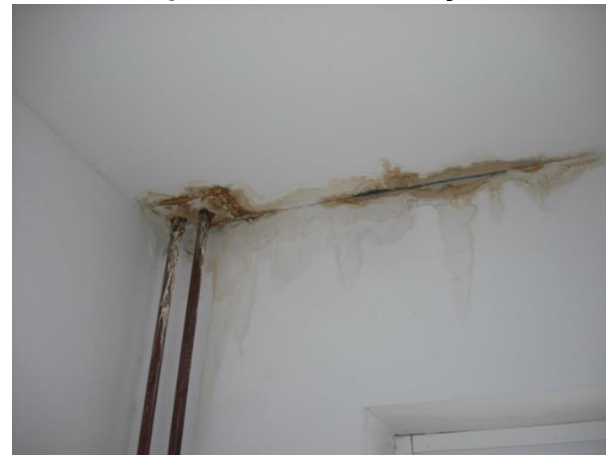
Износ уплотнительных резинок из-за отсутствия должного ухода
