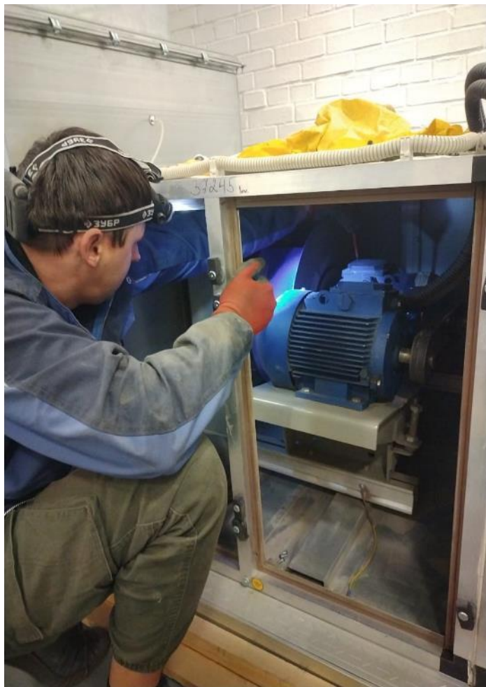
Проведение обслуживания и ремонта системы вентиляции паркинга
