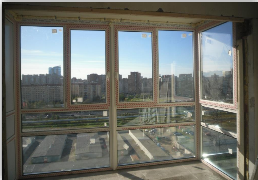
Снос фасадной стены и изменение фасадного остекления
