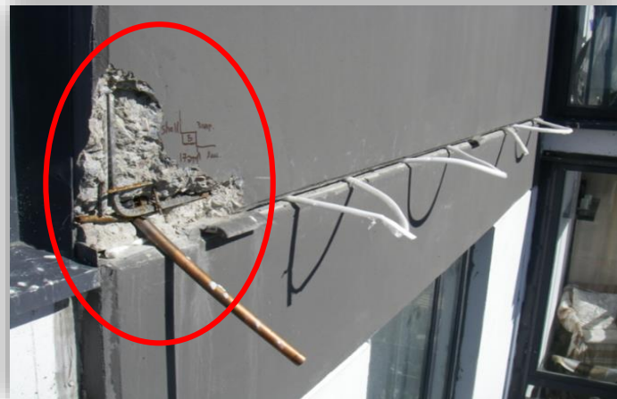
Вывод конденсата от кондиционера
