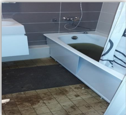
Затопление квартиры фекальными массами после слива в унитаз строительных смесей
