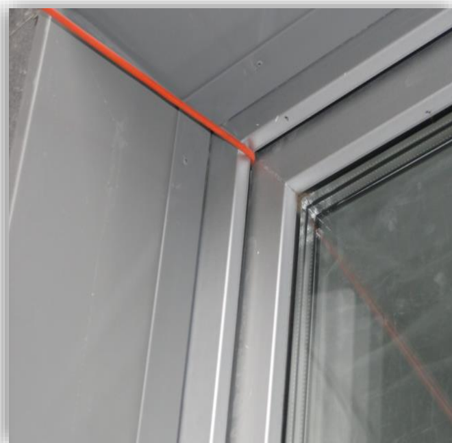
Проложен кабель через оконный притвор
