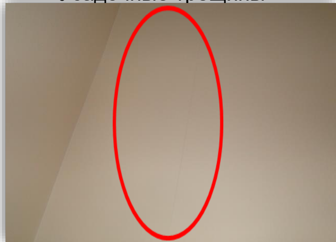
Усадочные трещины
