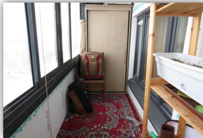
Нарушение правил эксплуатации лоджии: ковер на полу способствует появлению плесени
