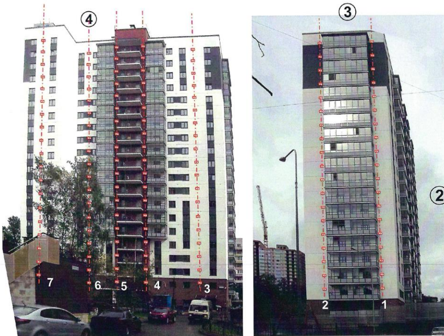
Оси размещения наружных блоков кондиционеров.
