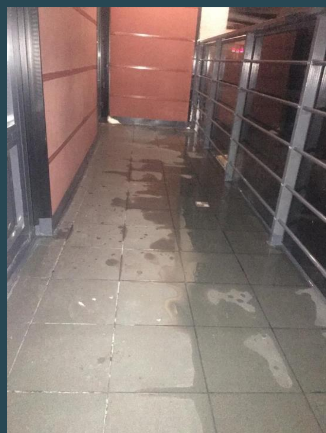
Разуклон плитки переходного балкона
