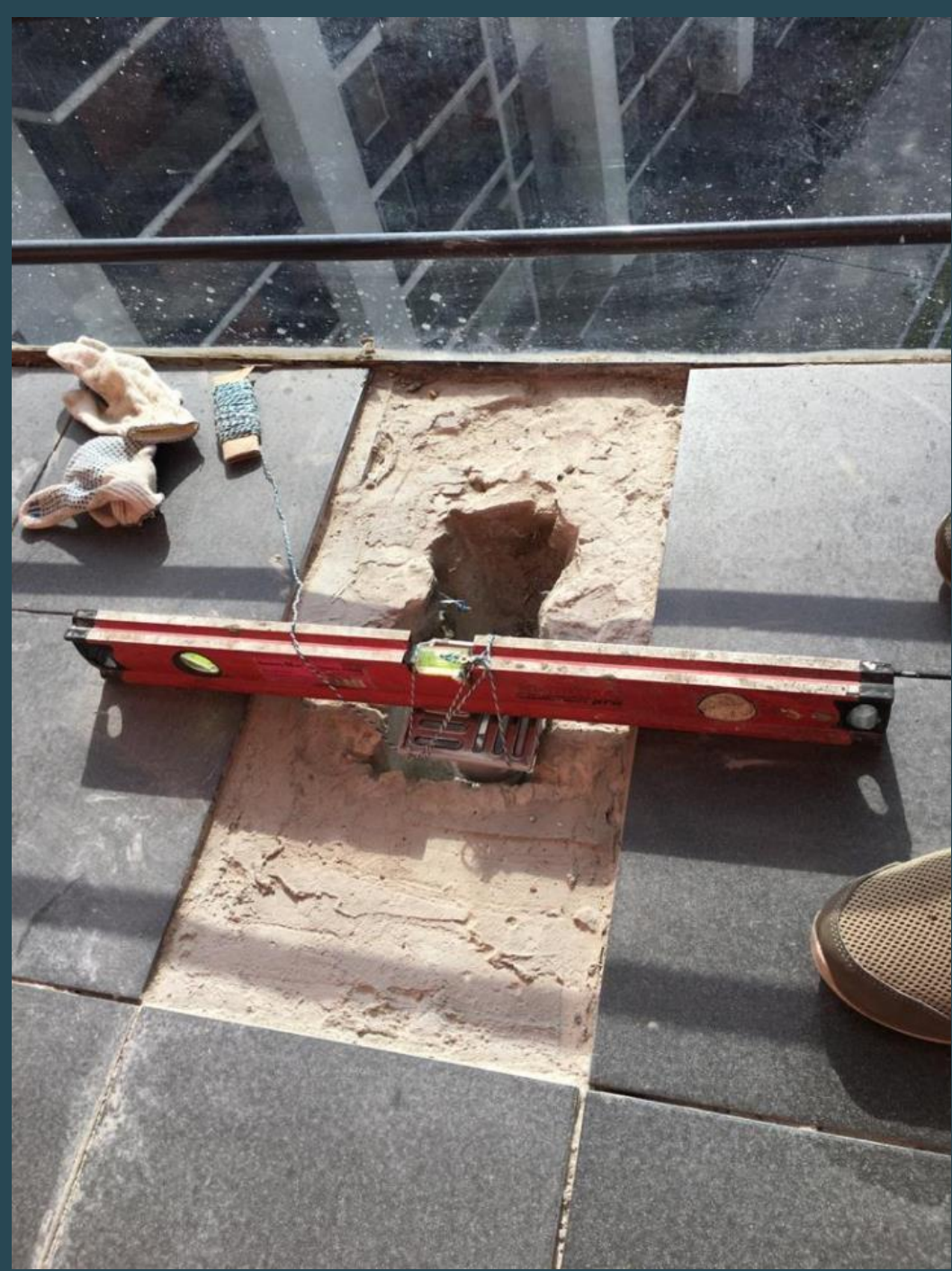
Разуклон плитки переходного балкона
