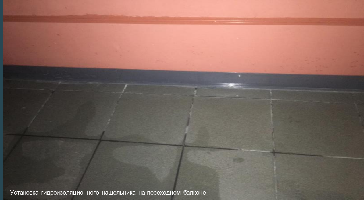
Гидроизоляция примыкания
