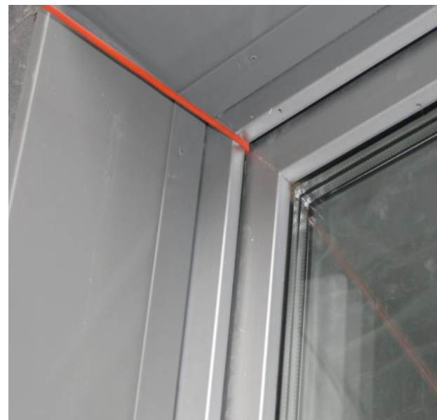
Проложен кабель через оконный притвор
