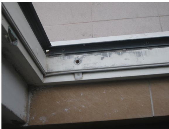
Износ уплотнительных резинок из-за отсутствия должного ухода
