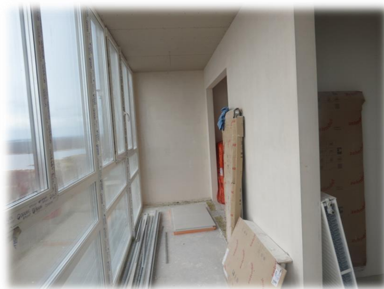
Изменение фасадного остекления и подшивка потолка
