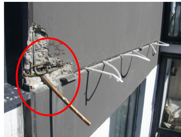
Вывод конденсата от кондиционера
