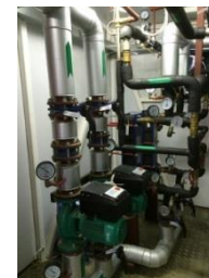
Система приготовления ГВС в ИТП
