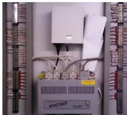
Контроллер системы диспетчеризации
