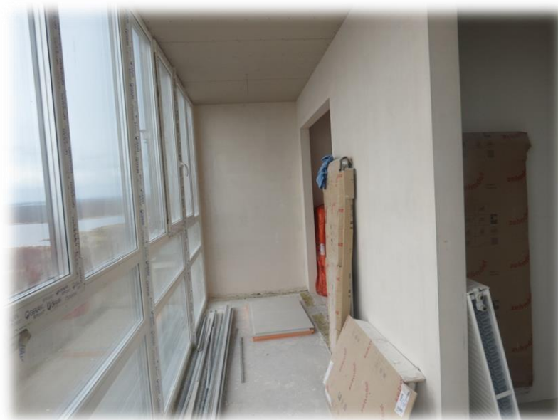
Изменение фасадного остекления и подшивка потолка
