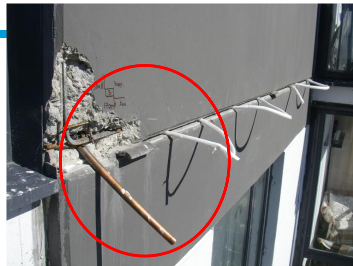
Вывод конденсата от кондиционера
