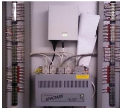
Контроллер системы диспетчеризации
