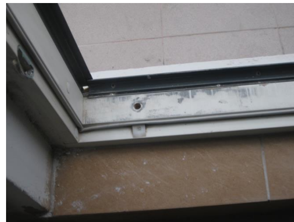
Износ уплотнительных резинок из-за отсутствия должного ухода
