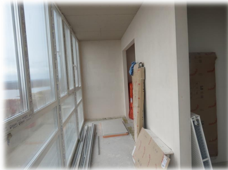
Изменение фасадного остекления и подшивка потолка
